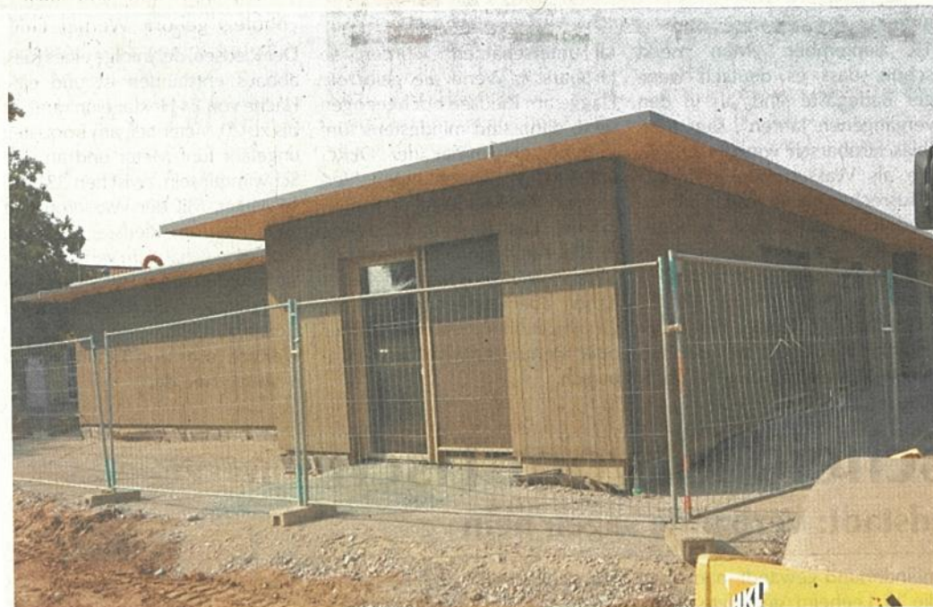
Ein auskragendes Dach dient sowohl der Verschattung als auch als Witterungsschutz und als überdachte Sitzmöglichkeit.
